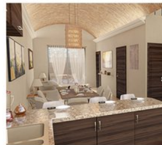
Bóveda de ladrillo en sala-comedor
